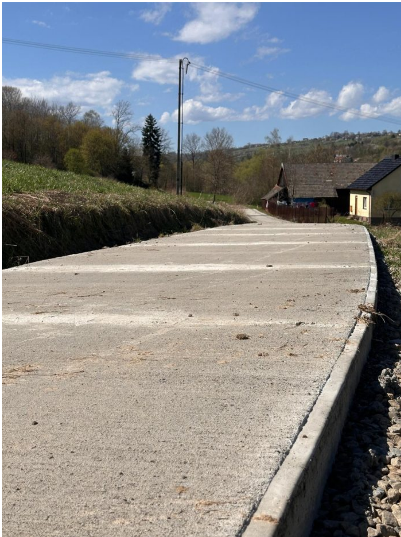
Droga Korzenna do Halasia w trakcie budowy
