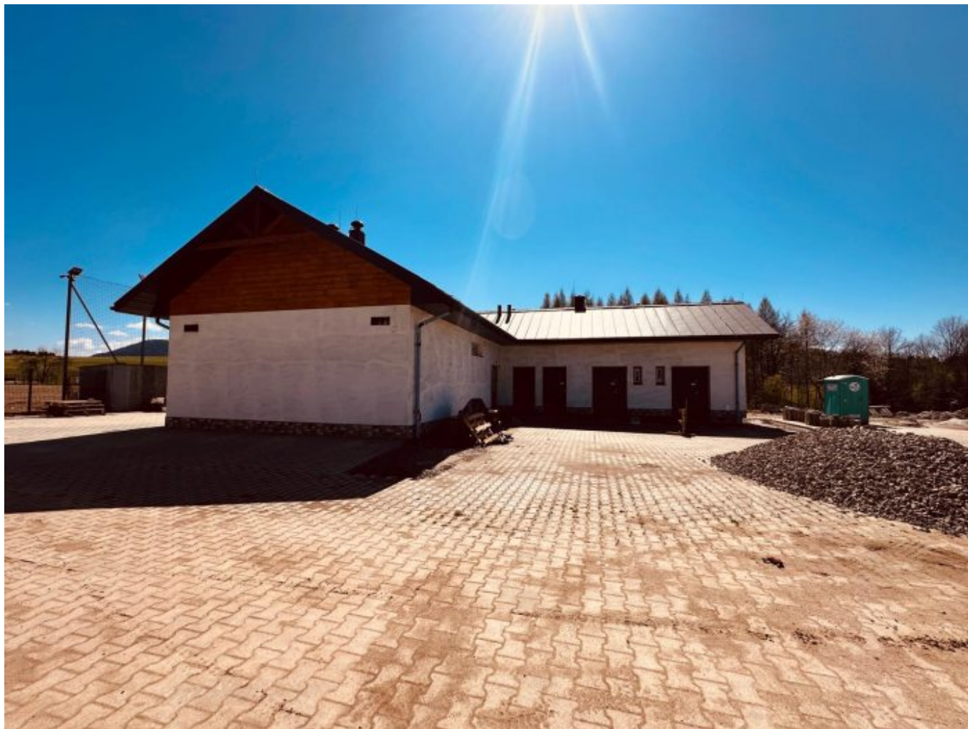
Ogólny widok na budowany obiekt
