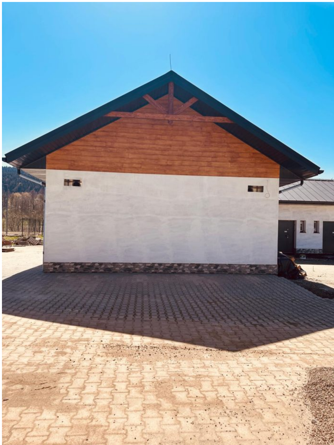
Szatnia w trakcie budowy
