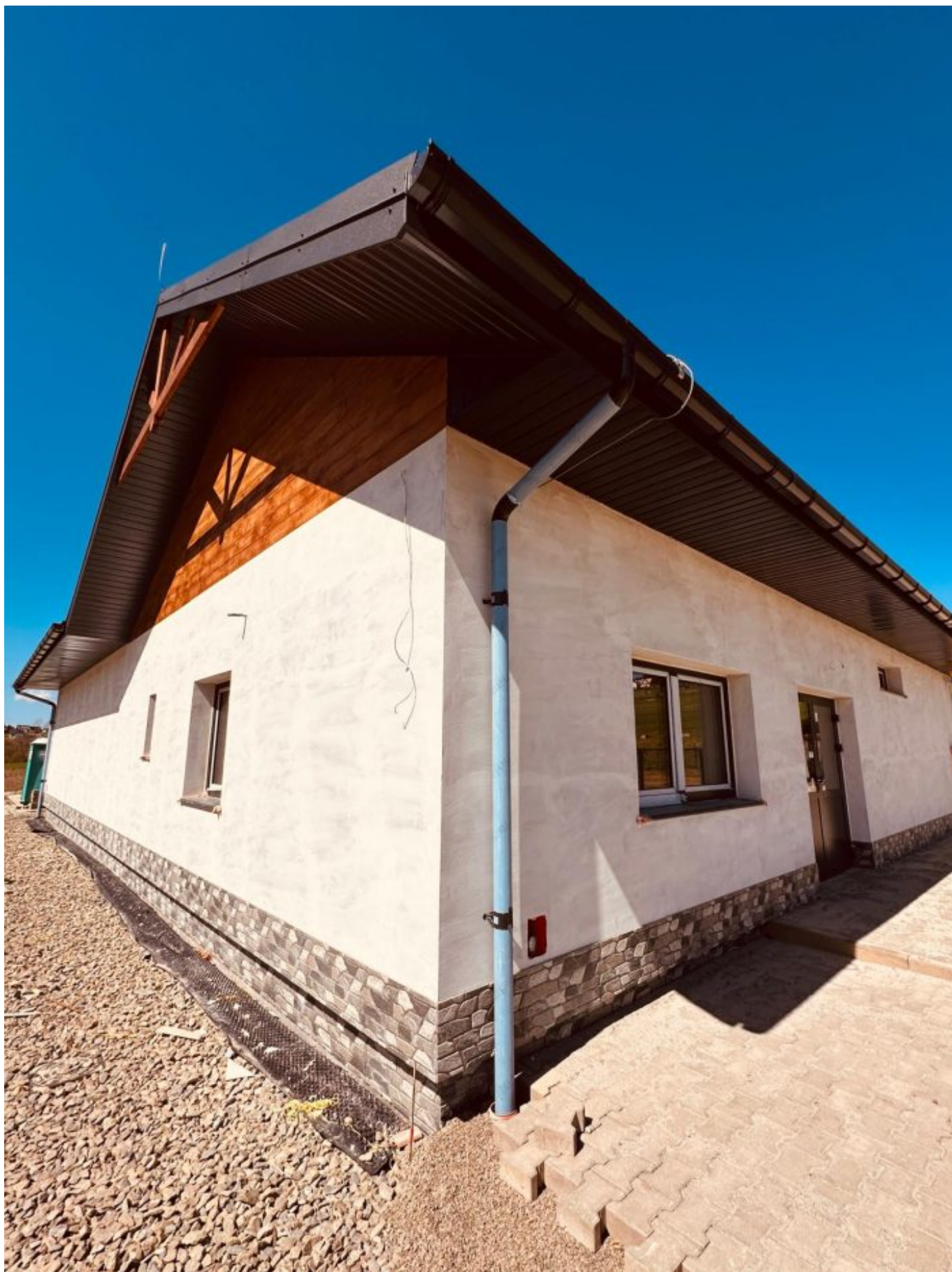
Szatnia w Mogilnie w trakcie budowy
