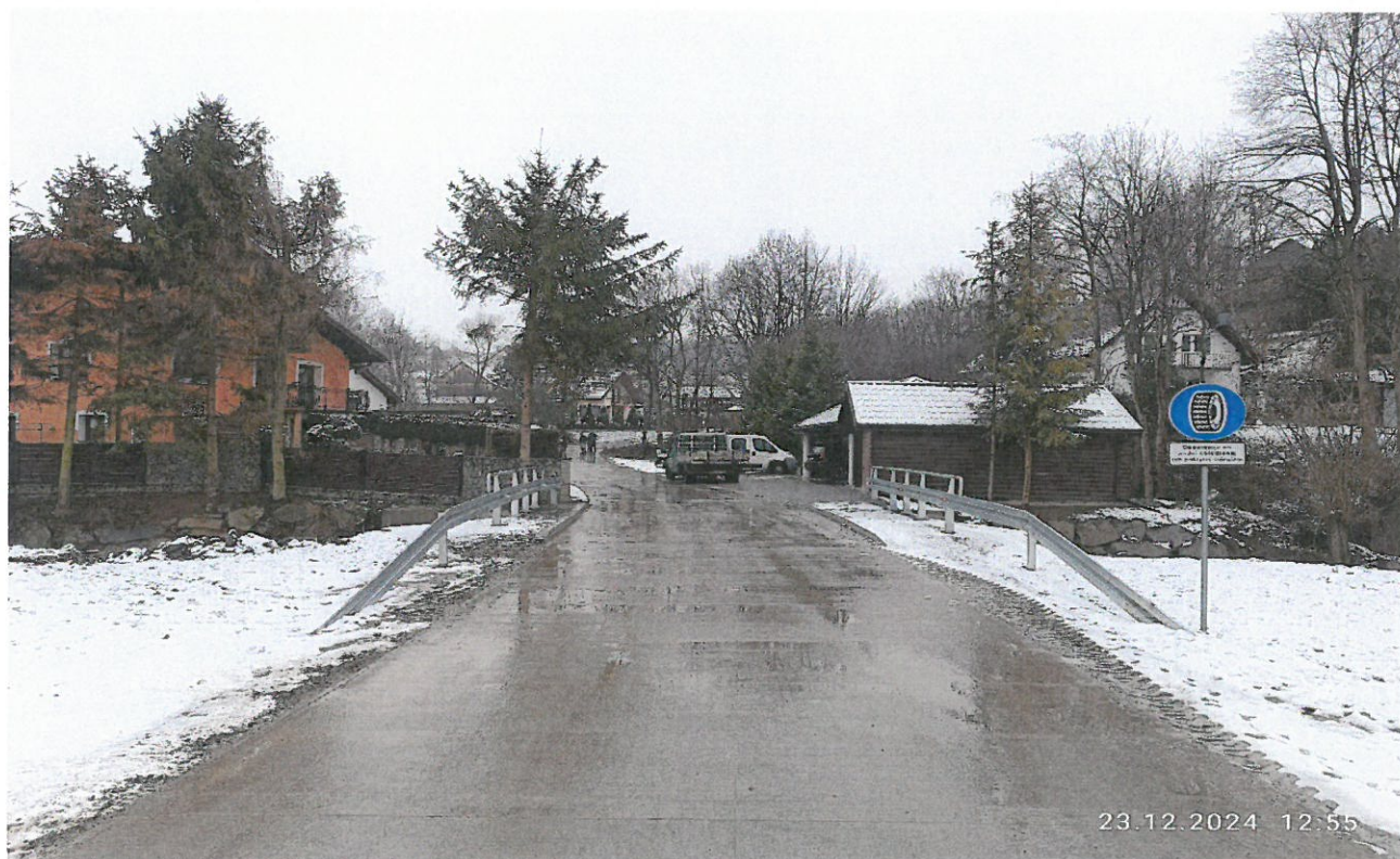
291417K Posadowa Mogilska Poddziale - Krużlowa Pagorek – przepust
