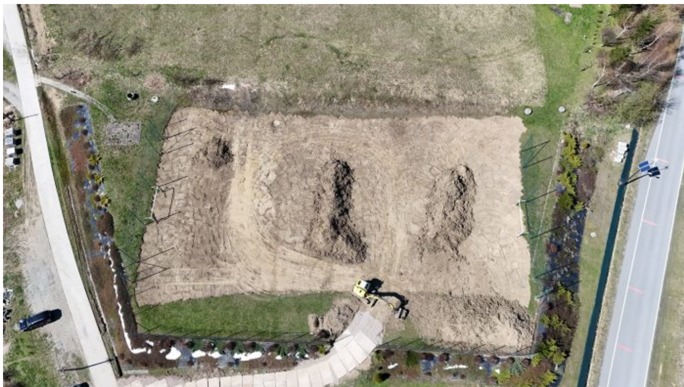
Początek prac przy budowie boiska w Posadowej Mogilskiej
