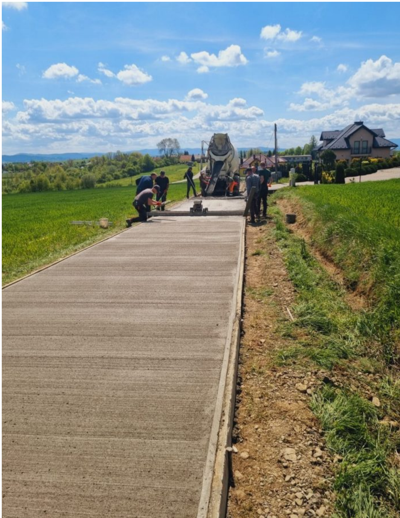
Układanie betonu zbliża się do końca.
