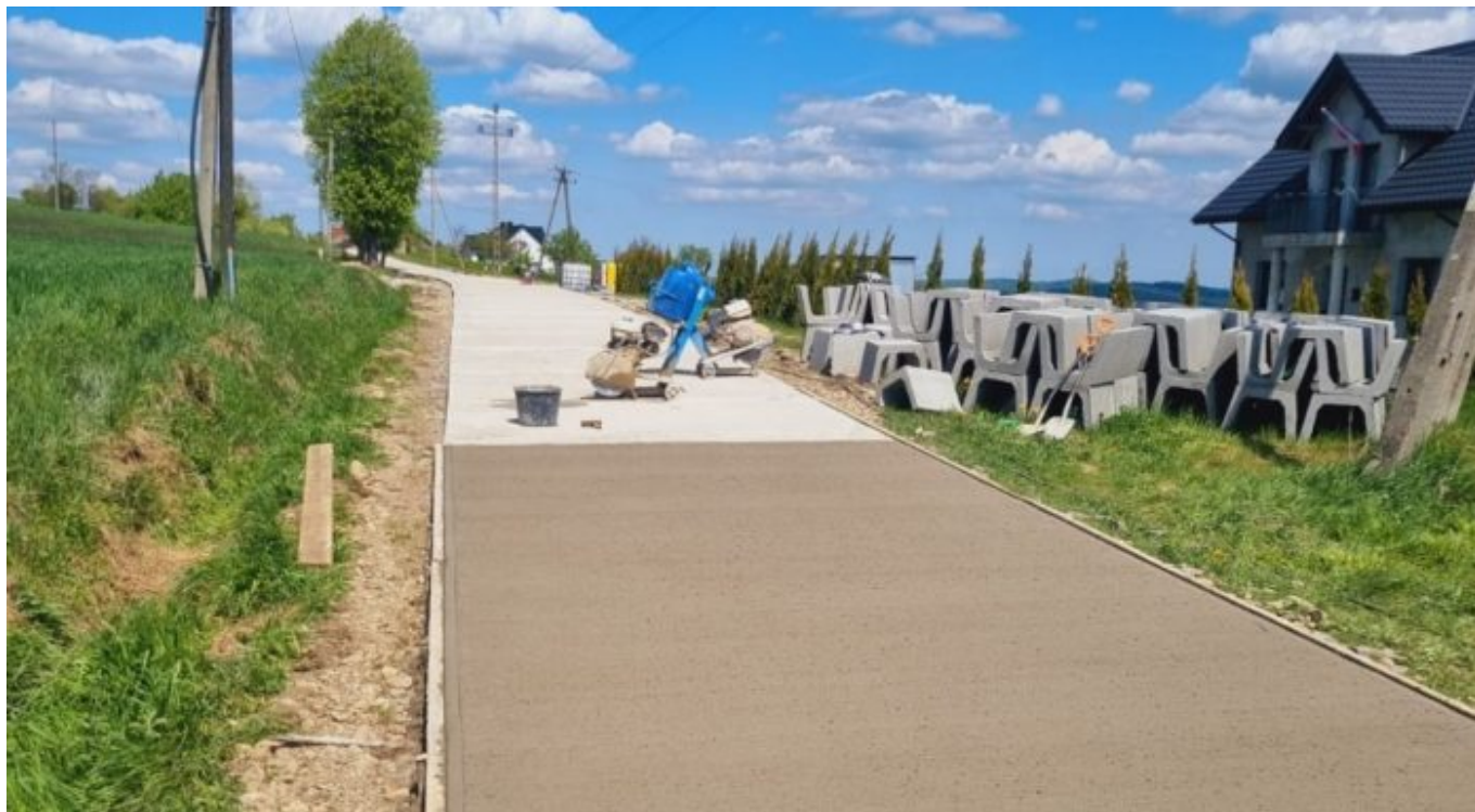
Ostatnia faza ukladania betonu.
