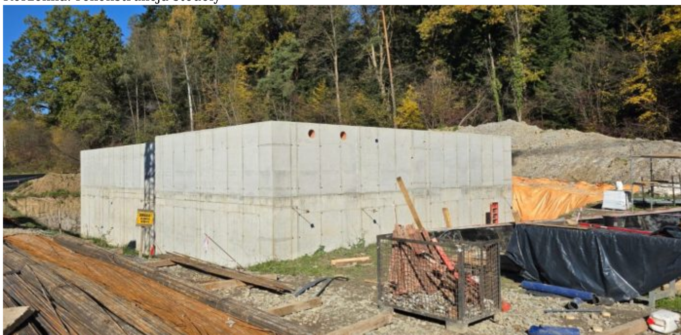
Łęka: budowa oczyszczalni ścieków
