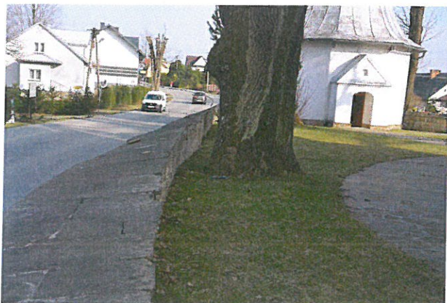
Widoczne fragmenty muru w dolnej części ogrodzenia przy kaplicy św. Anny. Widoczne pokrycie muru blachą.
