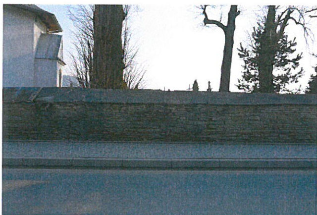
Widoczny mur od strony drogi powiatowej. Widoczne przemurowania muru na skutek osiadania w miejscach odwodnień z placu kościelnego. Na drugiej fotografii widoczny fragment muru w górnej części przy wejściu głównym. Widać uszkodzenia muru oraz nakrycia kamiennego. Brak naprawy doprowadzi do szybkiej destrukcji ogrodzenia.
