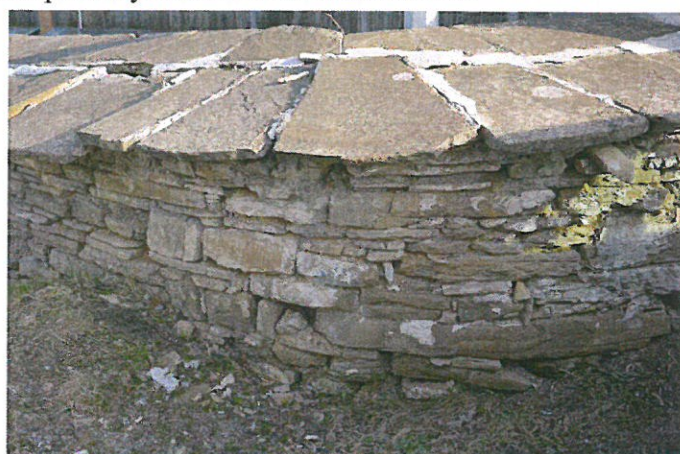
Na pierwszej fotografii widać połączenie muru z kaplicą w murze – widoczne odspajające się kamienie muru. Na drugiej fotografii widoczny fragment muru w górnej części przy wejściu głównym. Widać uszkodzenia muru oraz nakrycia kamiennego. Brak naprawy doprowadzi do szybkiej destrukcji ogrodzenia.
