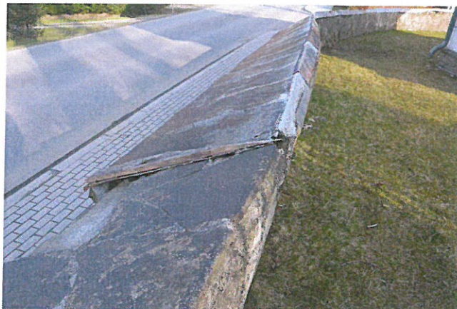
Widoczne fragmenty muru w dolnej części ogrodzenia przy kaplicy św. Anny. Widoczne pokrycie muru blachą.
