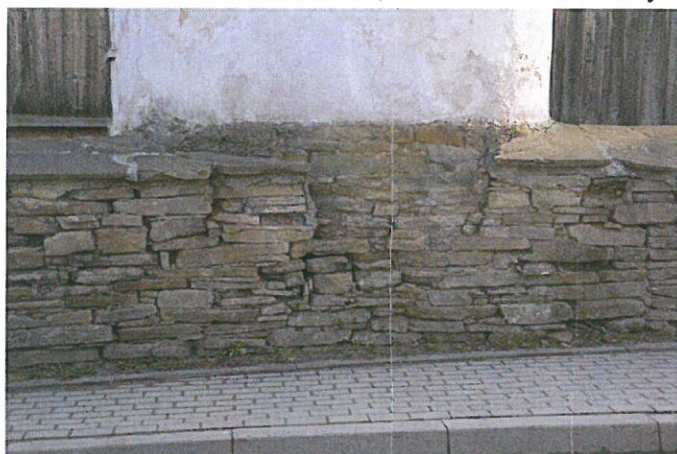
Na pierwszej fotografii widać połączenie muru z kaplicą w murze – widoczne odspajające się kamienie muru. Na drugiej fotografii widoczny fragment muru w górnej części przy wejściu głównym. Widać uszkodzenia muru oraz nakrycia kamiennego. Brak naprawy doprowadzi do szybkiej destrukcji ogrodzenia.
