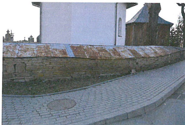
Widoczny mur w dolnej części ogrodzenia przy wejściu na plac kościelny przy kaplicy św. Anny. Widoczne uszkodzenia, rozwarstwienia mury oraz przechylenia na skutek osiadania.
