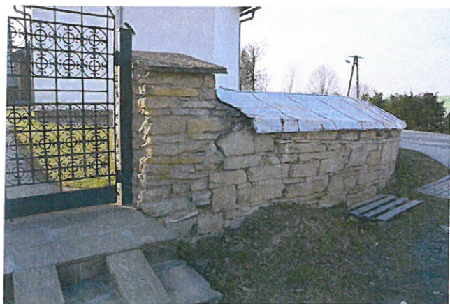
Widoczny mur w dolnej części ogrodzenia przy wejściu na plac kościelny przy kaplicy św. Anny. Widoczne uszkodzenia, rozwarstwienia mury oraz przechylenia na skutek osiadania.
