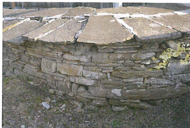
Widoczny mur od strony drogi powiatowej. Widoczne przemurowania muru na skutek osiadania w miejscach odwodnień z placu kościelnego. Na drugiej fotografii widoczny fragment muru w górnej części przy wejściu głównym. Widać uszkodzenia muru oraz nakrycia kamiennego. Brak naprawy doprowadzi do szybkiej destrukcji ogrodzenia.
